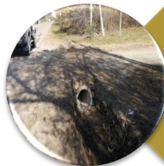
Обустройство системы отведения ливневых вод на ул. Центральная, с. Софье – Алексеевское
